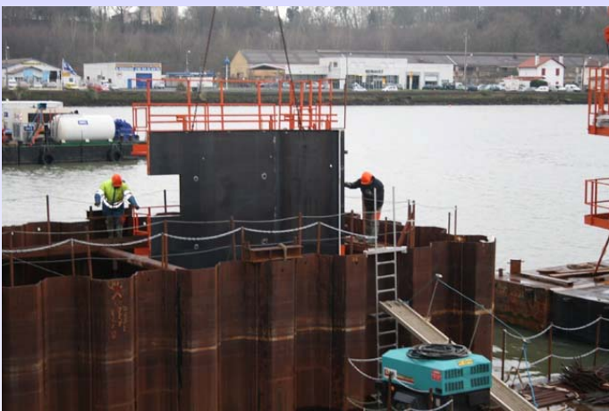
Instalación encofrado para la elevación del pilar P7
