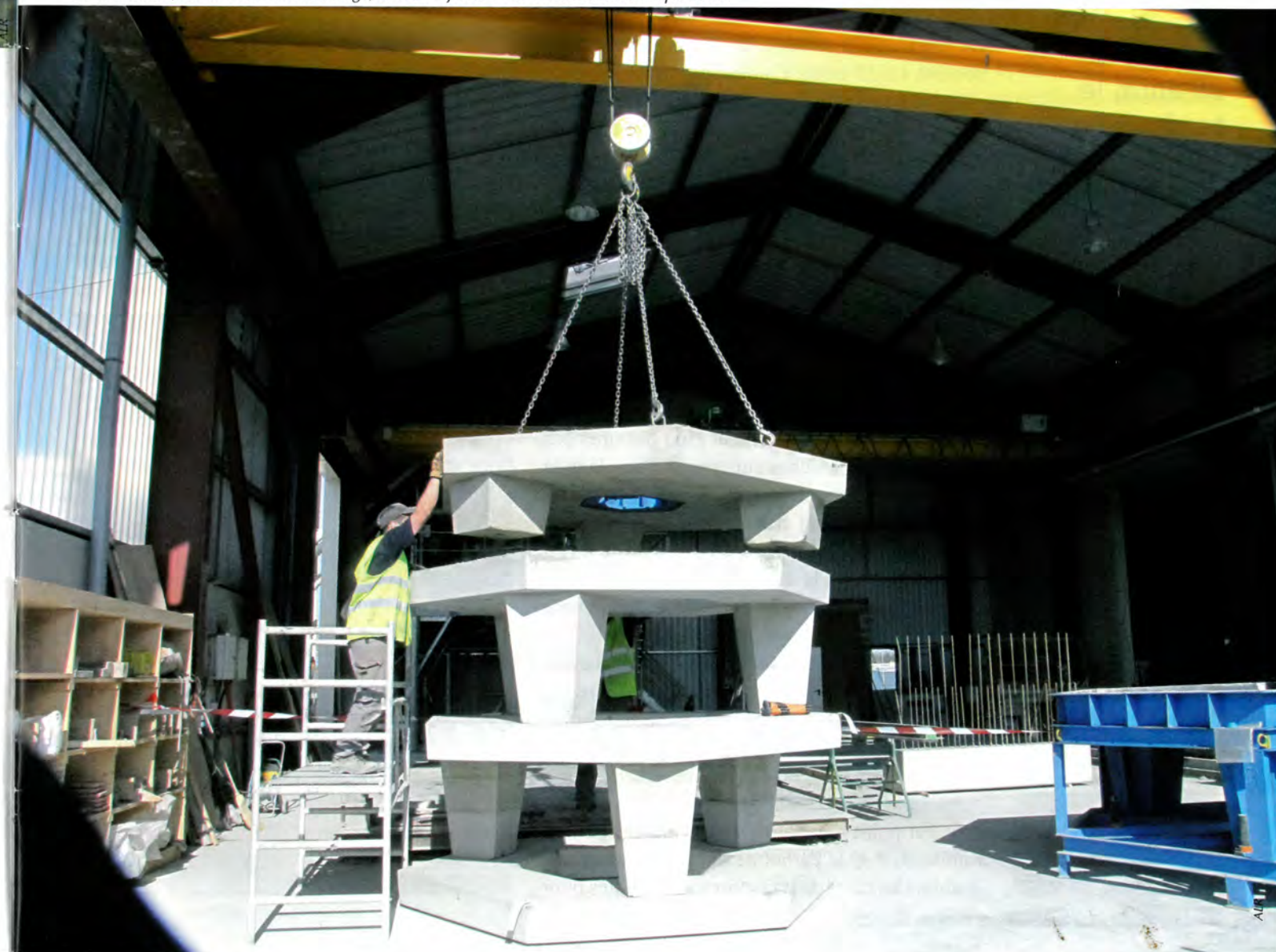
Le récif Babel, ici en cours d'assemblage, devrait rejoindre les fonds marins en septembre.
