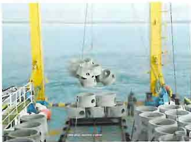
Mise en place de récifs artificiels au large de Vieux-Boucaux (40) par l'association Aquitaine Landes Récifs.
