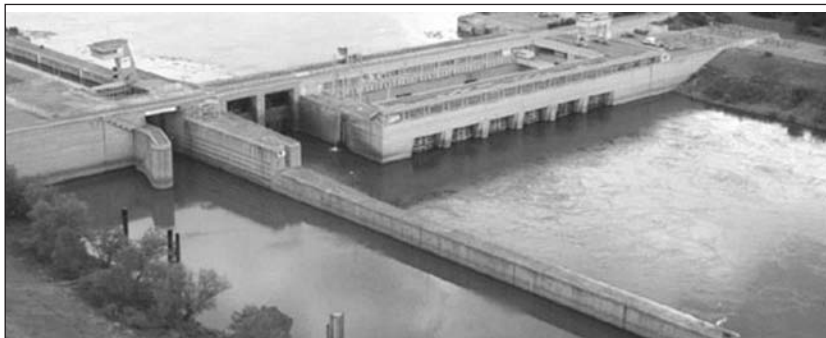
Centrale-écluse de Vallabrègues, où des aménagements en faveur des migrateurs, surtout l'alose, ont été réalisés (Photo C.N.R.)
