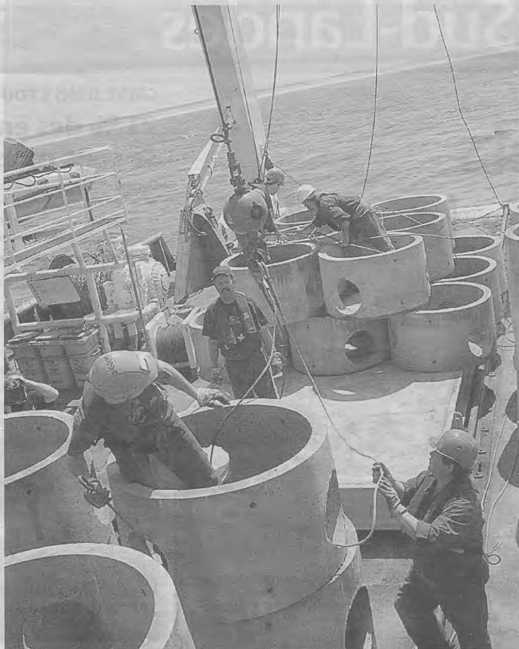
Les dernières buses formant les récifs artificiels implantés sur la côte Sud des Landes ont été immergées au large de Moliets
